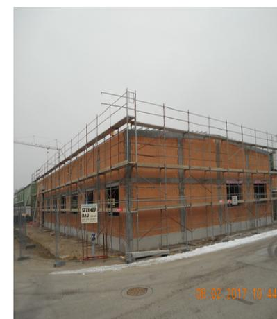
Es wurden Streifenfundamente hergestellt auf denen das 30 cm starke Ziegelmauerwerk (Außenmauerwerk) hergestellt wurde.
